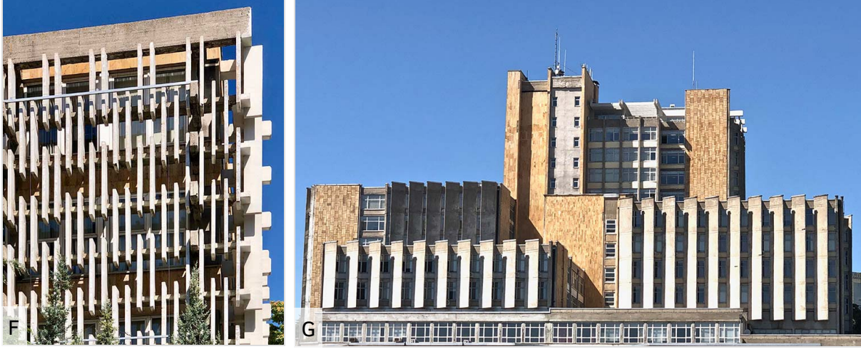
Şekil 12F, 12G. Sabih Kayan, Hacettepe Üniversitesi Merkez Kampüsü; güneş kırıcıların 50 yıllık performansı.
