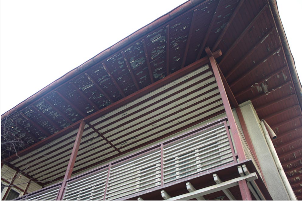
Şekil 18. S. Baydur Evi ahşap saçak, balkon tavanları, korkulukları ve strüktürü. Kaynak: Ankara'da İz Birakan Mimarlar Projesi Arşivi. Fotoğraf: Seçil Özcan, 2018.
