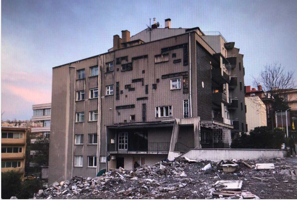
Şekil 8. Bay Mehmet Ali Sönmez Apartmanı giriş cephesi ve giriş saçağı. Fotoğraf: Elif Selena Ayhan Koçyiğit, 2020.
