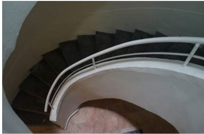
Şekil 18. Köker Apartmanı, merdiven kovası. Kaynak: Yazarın arşivi.
