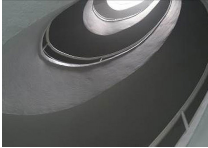
Şekil 16. Köker Apartmanı, merdiven kovası. Kaynak: Yazarın arşivi.
