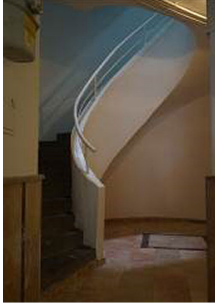
Şekil 17. Köker Apartmanı, merdiven kovası. Kaynak: Yazarın arşivi.
