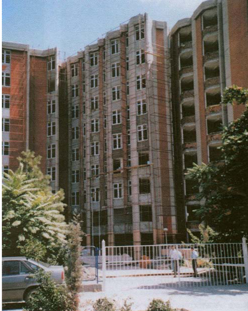
Şekil 28. Binanın onarımı veya kimliğinin yıkımı. Kaynak: Vanlı, 2003, s.10.
