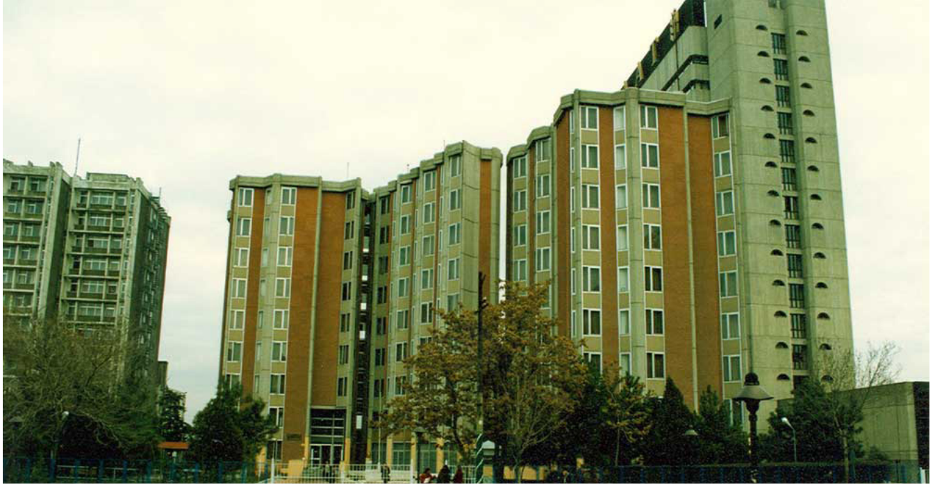
Şekil 6. Binanın genel görünüşü. Kaynak: Anonim, 2012, s.125.
