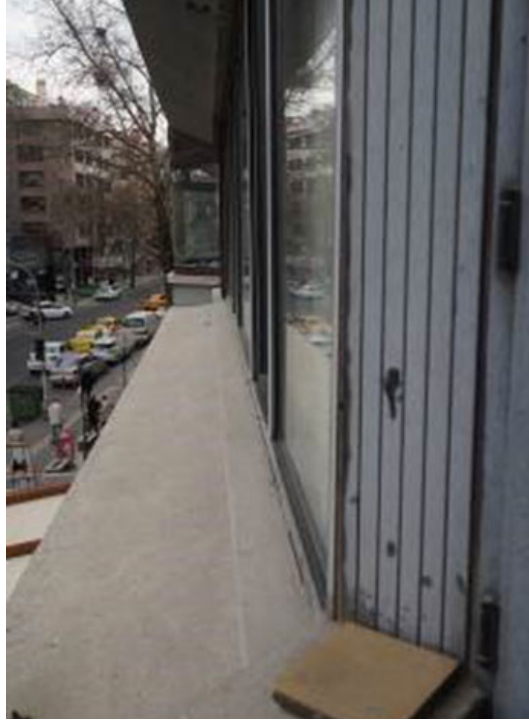
Şekil 21. Köker Apartmanı, cephe detayı. Kaynak: Yazarın arşivi.
