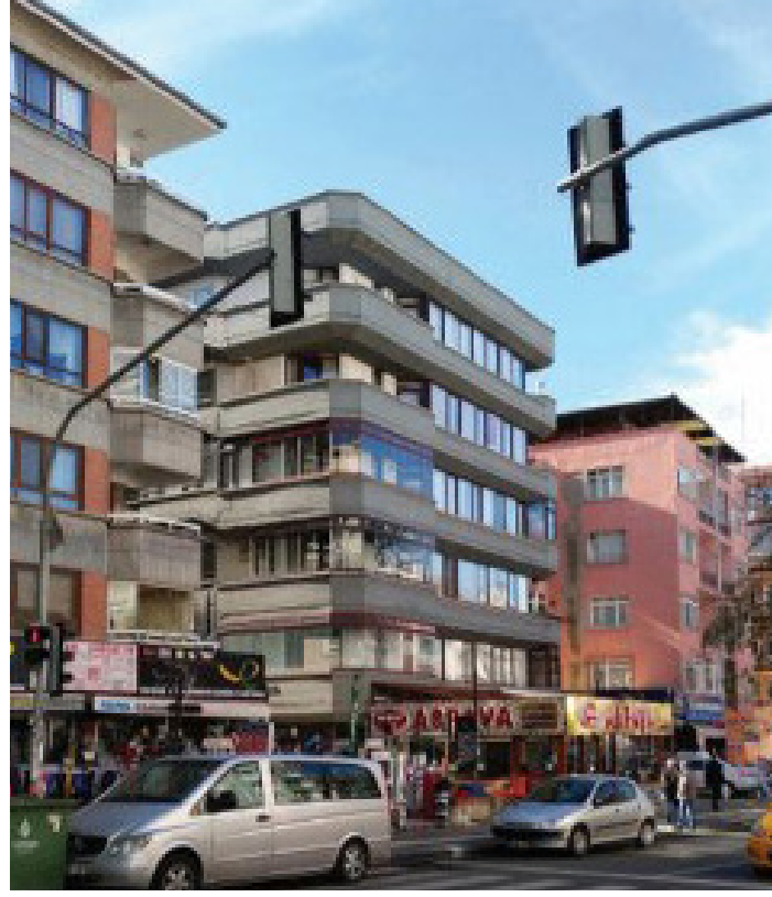
Şekil 12. Köker Apartmanı, güncel görünüm. Kaynak: Yazarın arşivi.
